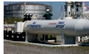
Іл. 43.11. Нафтоперекачувальна станція (Одеса – Броди)
